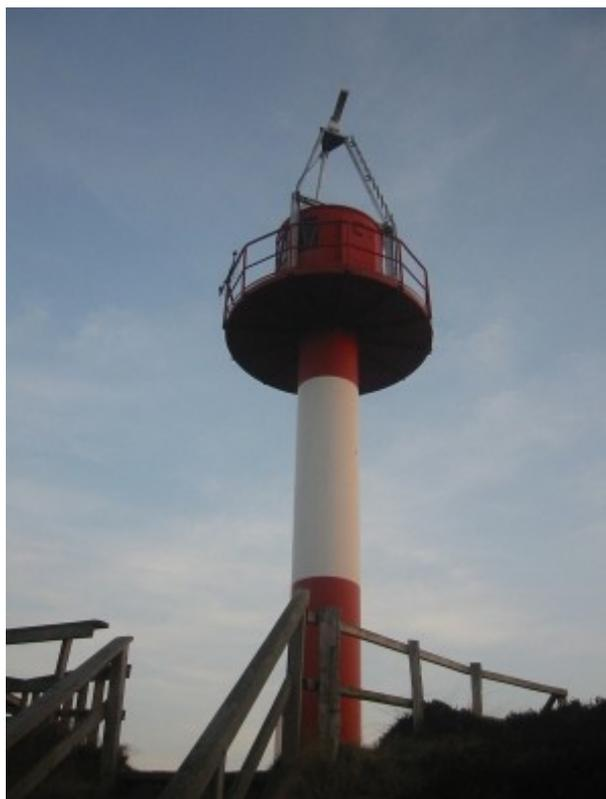
Abbildung 10: Unterfeuer mit der WaMoS II-Station auf Sylt bei Hörnum.
